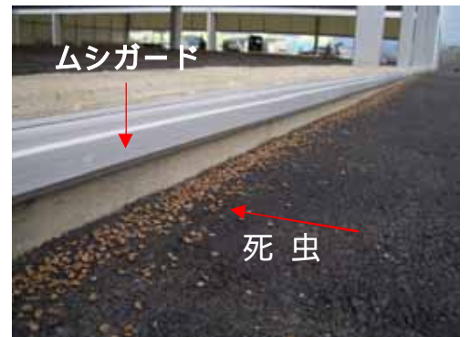
写真7 施工後の死虫。上に登ろうとするヤスデがすべてアスファルト上にノックダウンしている。
